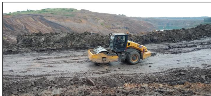
Gambar 5. Pemadatan Jalan Menggunakan Alat Compack Liugong
