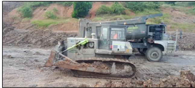
Gambar 3. Penyekrapan Jalan Menggunakan Bulldozer Zoomlion 220
