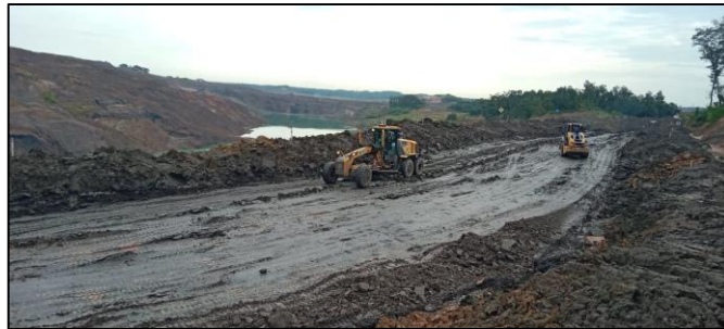
Gambar 4. Perataan Jalan Menggunakan Alat Moto Greder 4230D
